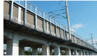
新幹線の防音壁
