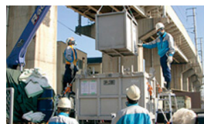
PCB搬出作業
