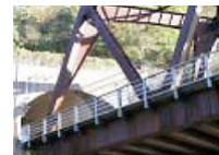
耐候性鋼材を使用した橋梁
